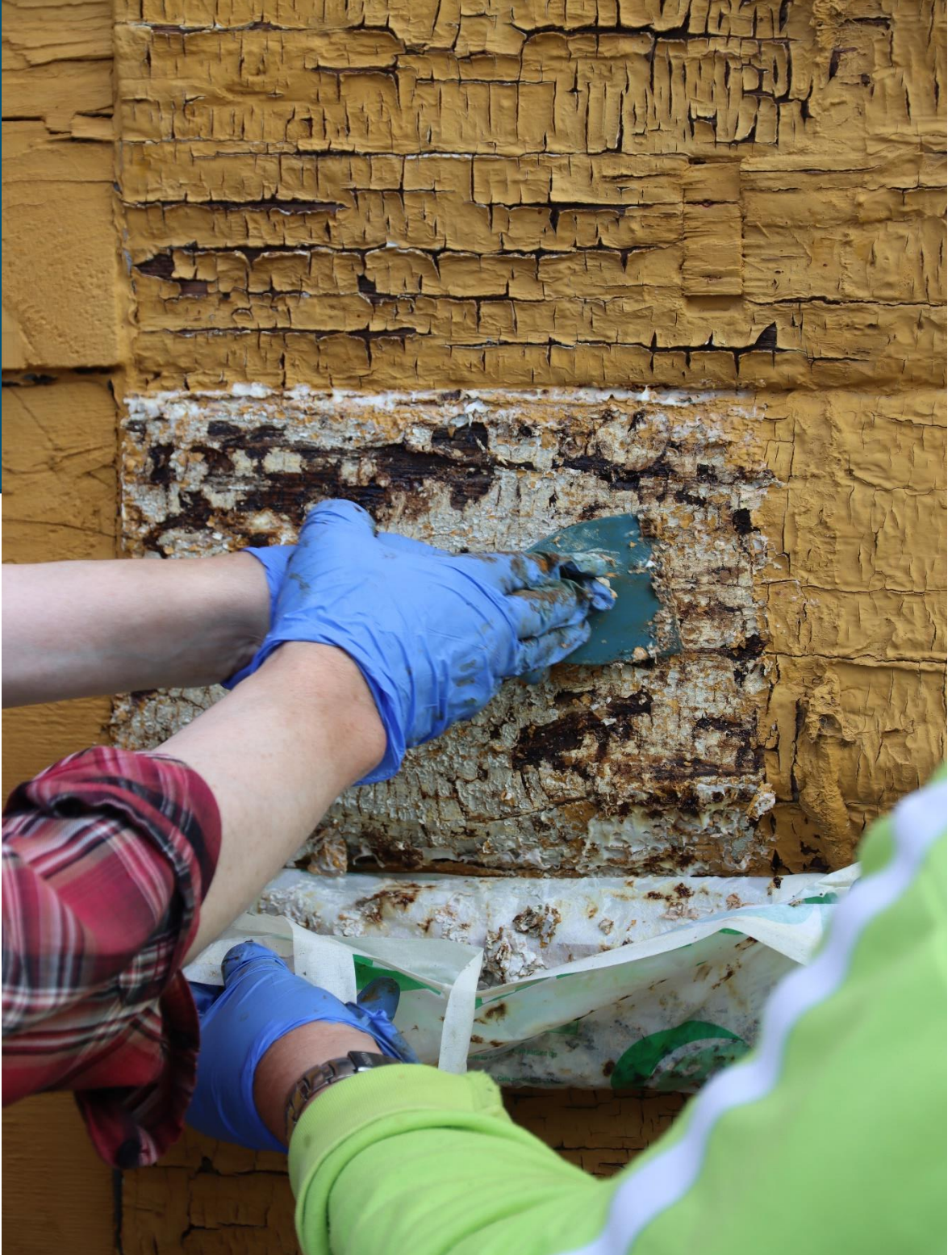
Opløst maling skræbes af med plastikspartel - ikke stålspartel
